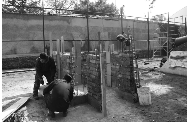
Fig. 16. Construcción del zócalo y cámara para la colocación del monumento.
