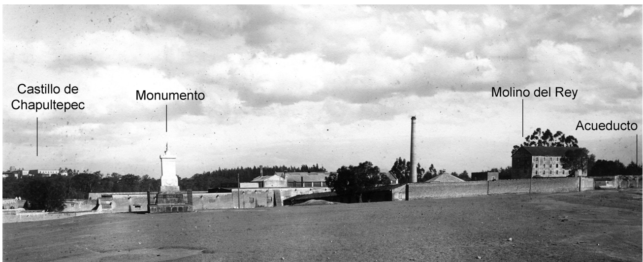
Fig. 1. Molino del Rey. Fuente: Fototeca de la Coordinación Nacional de Monumentos Históricos (CNMH), negativo 2113-85.
