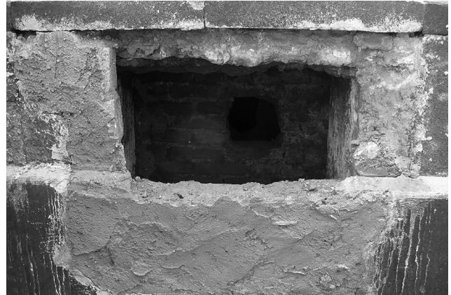
Fig. 19. Calas arquitectónicas de cimentación. Fotografía: Ma. de Lourdes López Camacho.
