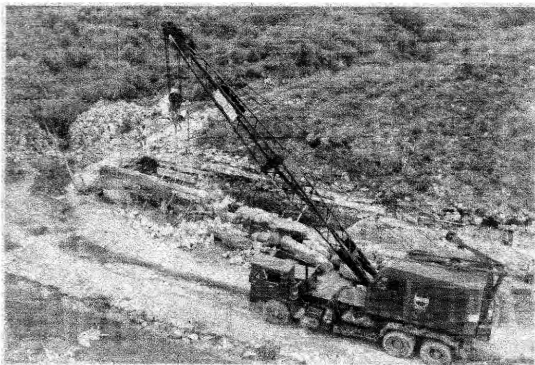
FIGURA 4 Vista de la grua durante las labores de reposición de los bloques de la cancha del juego de pelota sura.
