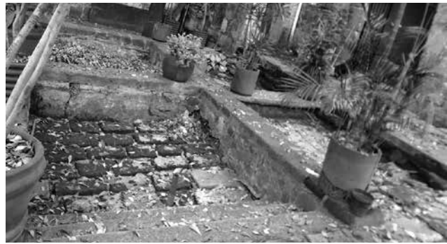
Fig. 4 Tinas ubicadas en el segundo patio de Casa Talavera. Fuente: fotografía provista por las autoras.
