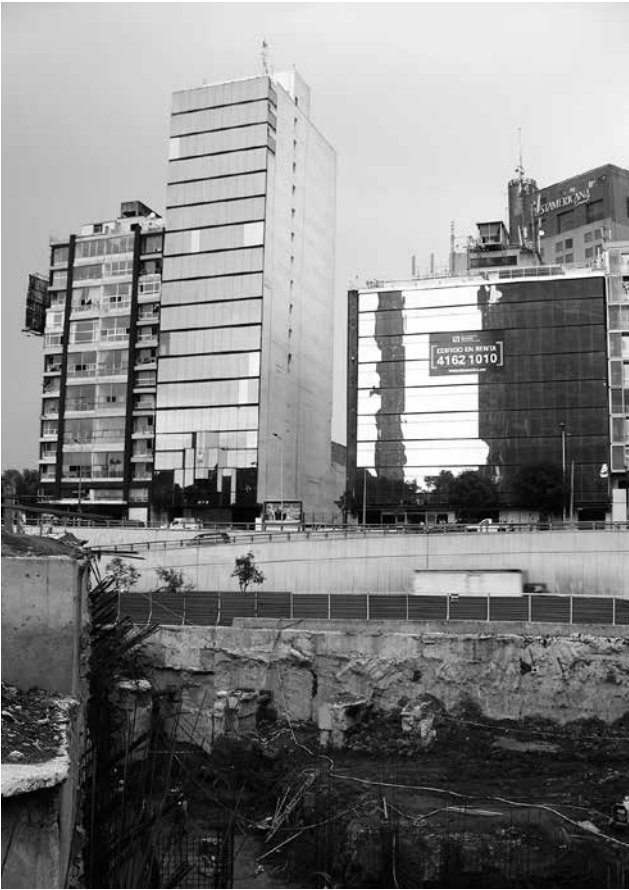
Fig. 23 Construcción de la Subestación Eléctrica Diana. Fuente: Maira Leticia Martínez Lemu, INAH.
