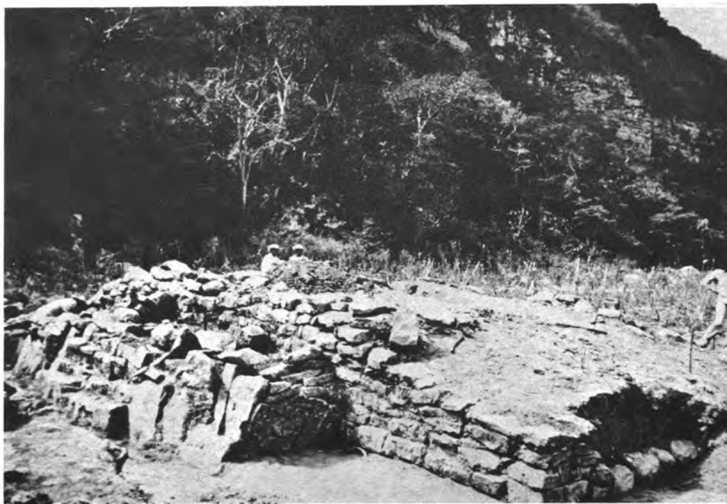
Fig. 5 Estructura 1 del sitio Las Avispas (A-4), una vez restaurada
