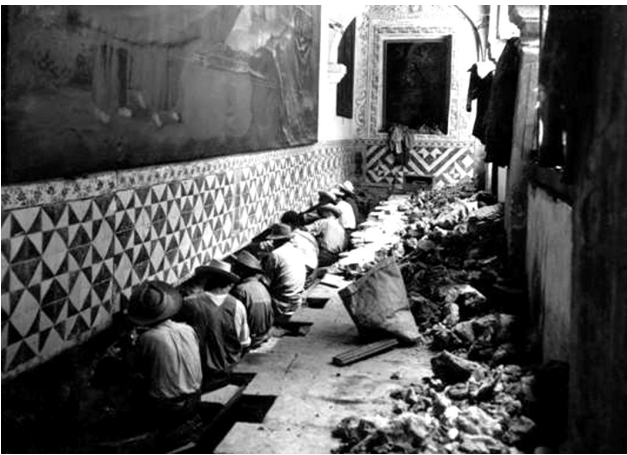
Fig. 5 Trabajos de restauración en 1947 (archivo de Churubusco).
