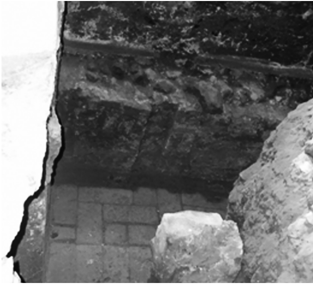
Fig. 12 Poyo en el muro sur.
