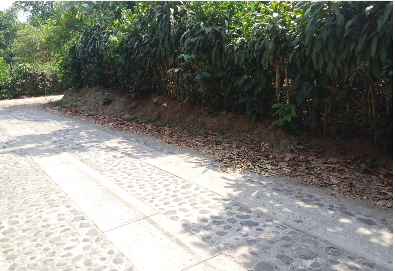
Fig. 8 Estructura del Grupo E parcialmente destruida por la construcción de un camino.
