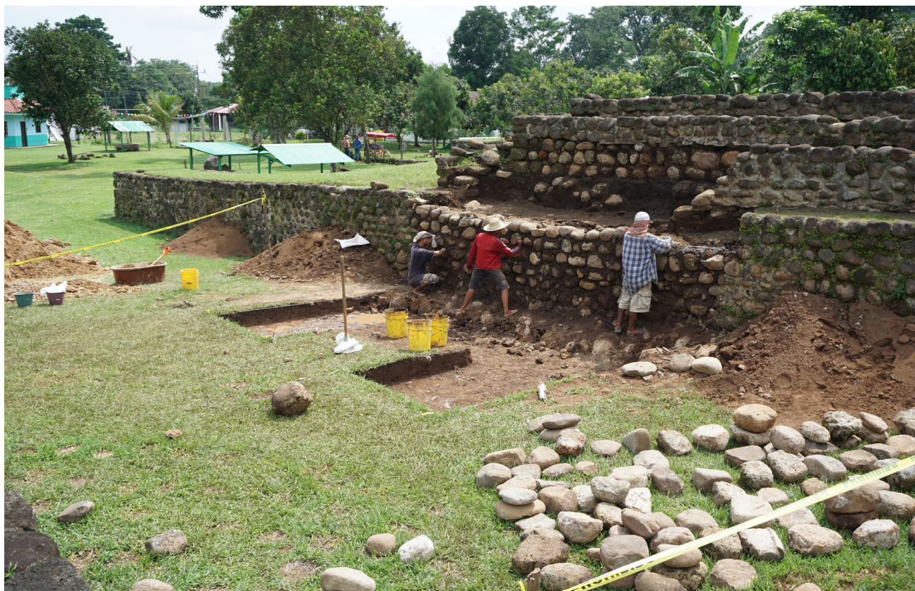
Fig. 10 Proceso de restauración de área colapsada de la plataforma basal de la estructura 125 y de la esquina sureste de la estructura 125-B en el Grupo F.
