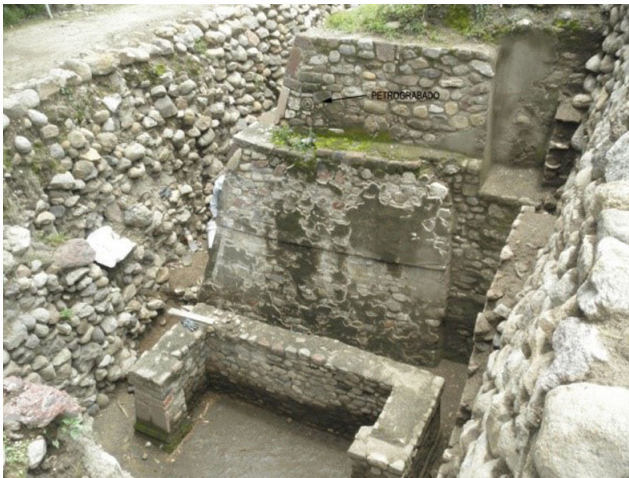
Fig. 20 Esquina NW. Primer y segundo cuerpo. Vista de oeste a este.
