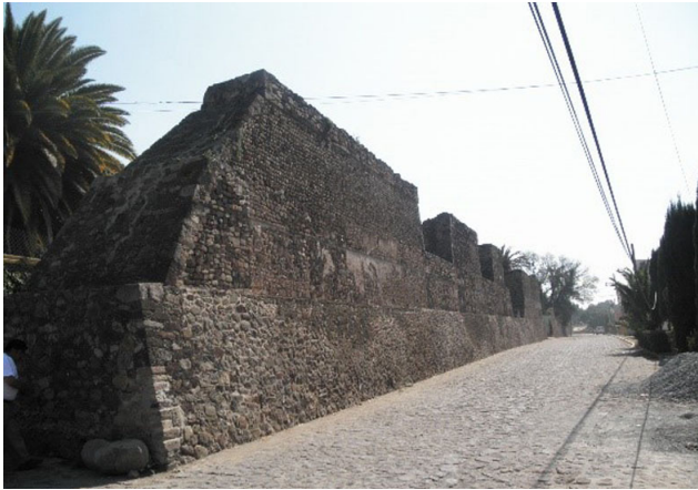
Fig. 34 Sección norte de la plataforma del recinto sagrado. Vista de norte a sur.
