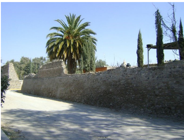
Fig. 36 Muro lateral norte de la fachada principal del recinto sagrado. Vista de sur a norte.
