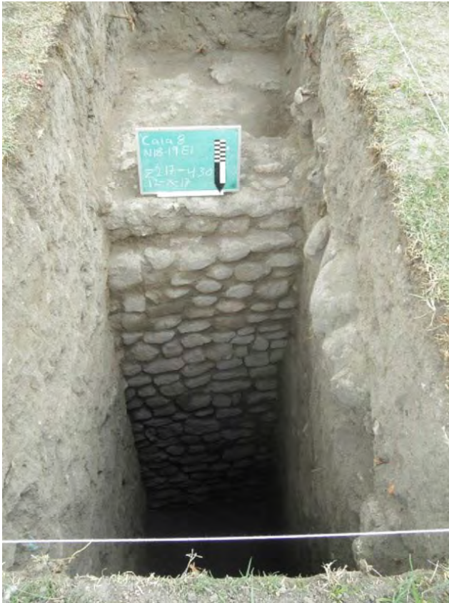
Fig. 39 (izq. arriba) Detalle del paramento que forma el pasillo de acceso. Éste presenta como remate, al igual que los otros, un muro vertical ligeramente remetido. Vista de norte a sur.
