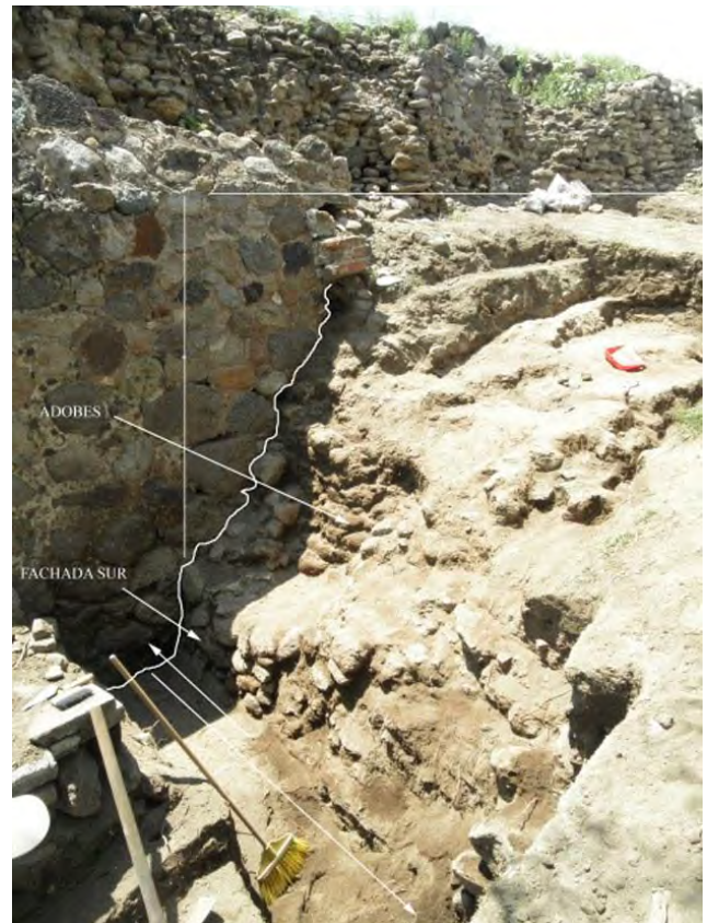
Fig. 19 Detalle de la fachada sur de la plataforma. El paramento debió estar al nivel del descanso y desplantar por debajo del nivel de la calle Aztecas y a ras de la margen norte de la barranca. Vista de este a oeste.
