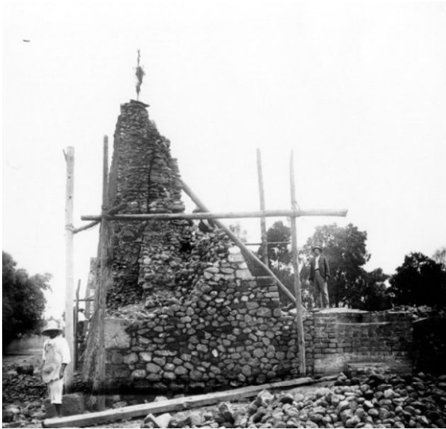
Fig. 9 Trabajos de reconstrucción, esquina de las calles Aztecas y San Francisco. En la foto se puede observar la separación entre la línea de contacto de los paños adosados en la fachada principal. El engrosamiento del cuerpo de la fachada principal hacia el exterior se debe a la superposición arquitectónica. Vista de sur a norte. Fuente: SINAFO. 1920 (Mid 77_20140827-134500:679838, catálogo 679838) (recuperado de: < https://mediateca.inah.gob.mx/repositorio/islandora/object/fotografia%3A454334 >).
