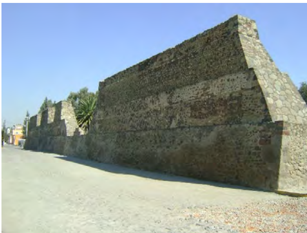
Fig. 52 Fachada exterior del mismo paramento. Al centro el asta bandera. Vista de sur a norte. El gráfico muestra los diferentes criterios de restauración aplicados en este muro: el coronamiento del extremo norte se reconstruyó con almenas, en tanto que el otro simplemente se consolidó y se enrasó el coronamiento. Los extremos se reconstruyeron en cuerpos escalonados y en talud. Vista de sur a norte.
