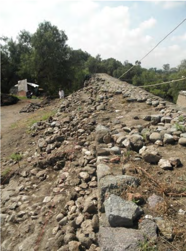
Fig. 36 Detalle de la imagen de la figura 35. Vista de norte a sur.
