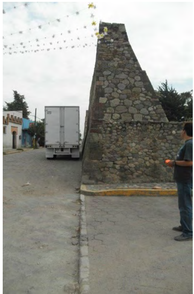
Fig. 54 Estado actual del cuerpo de la plataforma en la esquina de las calles Aztecas y San Francisco. Vista de sur a norte.
