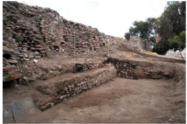
Fig. 27 Adosamiento de un paramento vertical y una banqueta en la fachada oeste de la plataforma. Éstos desplantan sobre el piso del descanso del primer cuerpo, lado sur.
