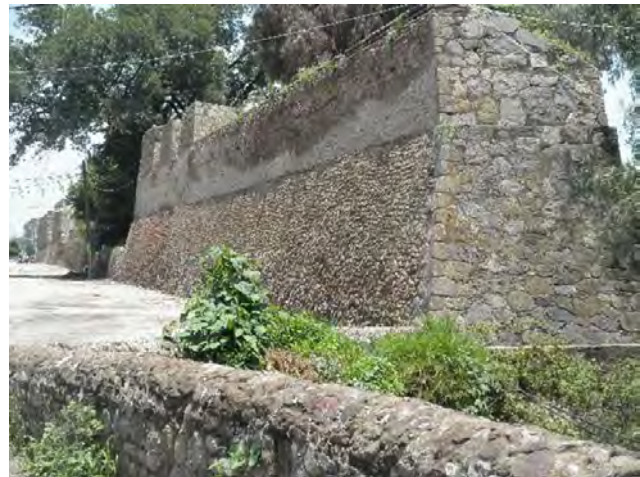
Fig. 3 Muro lateral sur, vano de acceso y muro lateral norte de la fachada principal de la plataforma del recinto sagrado. Al fondo la sección norte. Vista de sur a norte.
