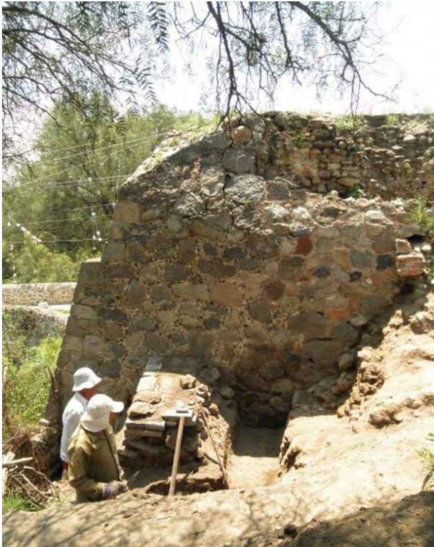
Fig. 20 Detalle del paramento en talud de la fachada sur. Vista de este a oeste.
