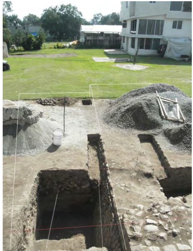
Fig. 24 Panorámica de la cala y pozo de sondeo. El muro sigue hacia el este, aunque debe doblar hacia el sur y posteriormente al este. Las líneas blancas muestran nuestra propuesta. Vista de oeste a este.
