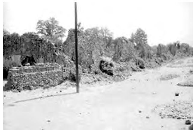
Fig. 56 Barda del huerto del convento y calle de San Francisco. En la foto se puede apreciar el derrumbe en varias secciones de la barda. Los restos corresponden a la cara interna del cuerpo norte de la plataforma del recinto sagrado. Vista de oeste a este. Fuente: SINAFO. 1960 (Mid 77_20140827-134500:300441, catálogo 300441, Pibarra, 2009) (recuperado de: < https://mediateca.inah.gob.mx/repositorio/islandora/object/fotografia%3A271015 >).
