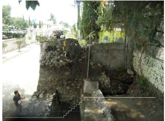
Fig. 44 Los peldaños debajo del estrato de tierra en talud. Vista de sur a norte.
