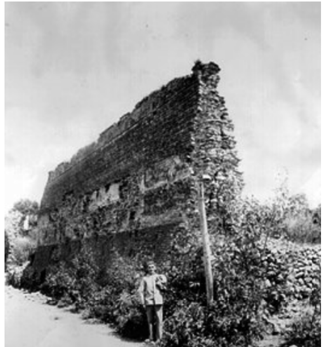
Fig. 8 Estado en que se encontraba el paño adosado de la última etapa constructiva. Sección norte, entre las calles Aztecas y San Francisco. Vista de sur a norte. Fuente: SINAFO, 1920 (Mid 77_20140827-134500:416617, catálogo 4166) (recuperado de: < https://mediateca.inah.gob.mx/repositorio/islandora/object/fotografia%3A360596 >).
