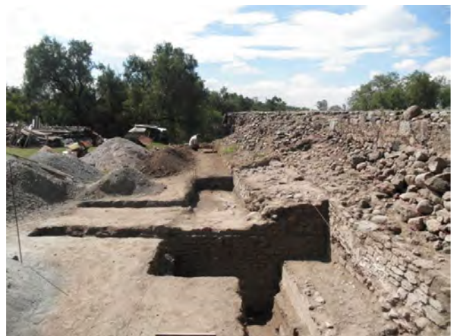
Fig. 25 Detalle del paramento del segundo cuerpo. Se observa cómo es rematado por un paramento vertical ligeramente remetido como su contraparte sur. Vista de norte a sur.
