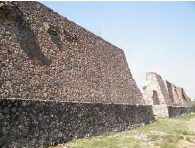
Fig. 5 Panorámica general de la sección norte de la plataforma, parte interna. Vista de sur a norte.
