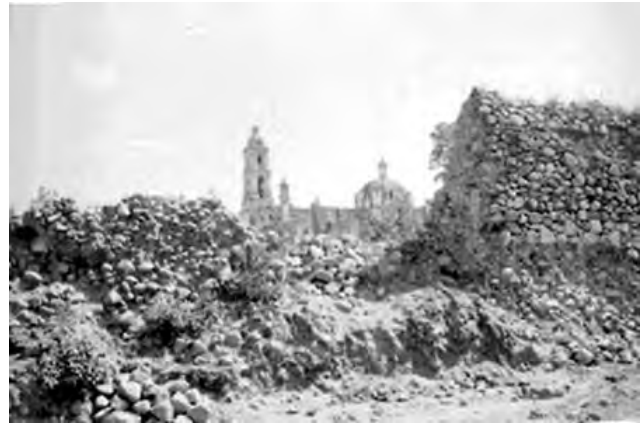
Fig. 55 Detalle de la barda del huerto del convento. Al fondo, la torre de la iglesia de San Luis Obispo. Vista de sur a norte. Fuente: SINAFO 1960 (Mid. 77_20140827-134500:300442, catálogo 300442, Pibarra, 2009) (recuperado de: < https://mediateca.inah.gob.mx/repositorio/islandora/object/fotografia%3A271016 >).
