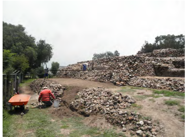
Fig. 21 La línea en color negro indica el primer y segundo cuerpo en la fachada norte del edificio. Vista de oeste a este.
