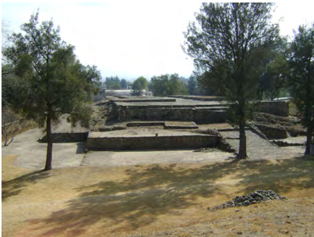
Fig. 1 Fachada principal del edificio antes de los trabajos de conservación y restauración (2010). Vista de oeste a este.
