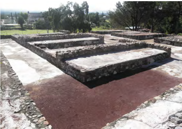
Fig. 38 Reintegración del relleno de los muros medianeros de las habitaciones. Vista de norte a sur.
