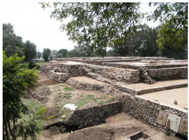
Fig. 18 Panorámica de la fachada norte. En primer término y a la izquierda, el brazo transversal norte que da forma de cruz latina al diseño en planta del primer cuerpo del edificio. A la derecha, el muro del eje mayor que forma el cuerpo frontal de la fachada principal.
