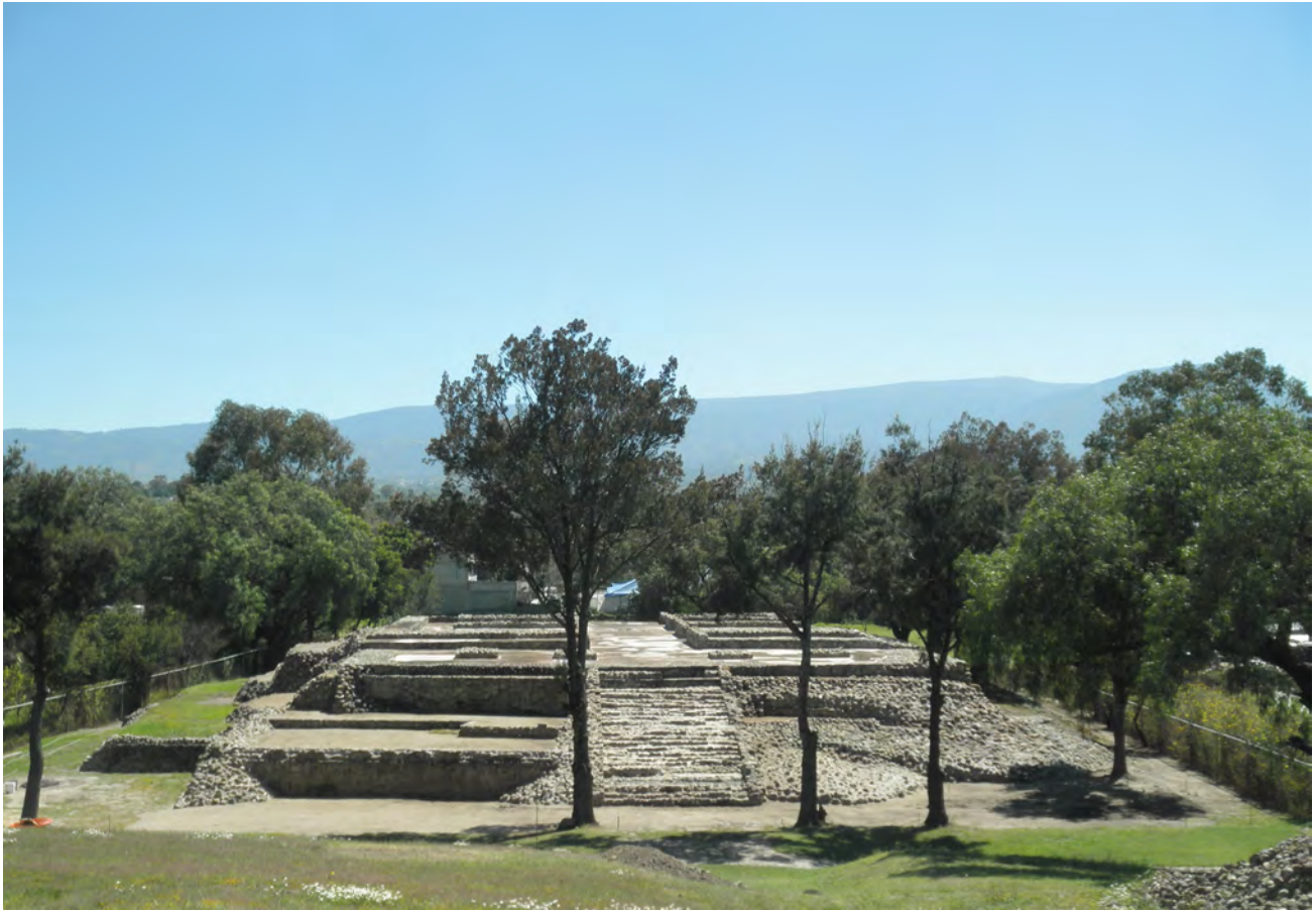
Fig. 43 Panorámica general del edificio al término de los trabajos de conservación y restauración arquitectónica. En el gráfico se puede apreciar la reintegración de la base o núcleo expuesto de la escalinata. Vista de oeste a este
