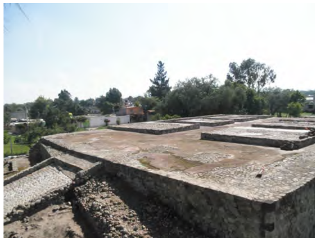
Fig. 35 Recinto superior antes de los trabajos. Esquina SW. Vista de sur a norte.
