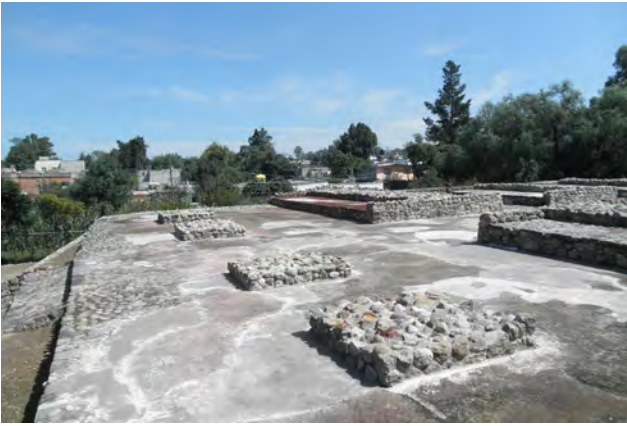
Fig. 37 Reintegración del relleno de los pilares del pórtico. Proceso terminado. Vista de sur a norte.
