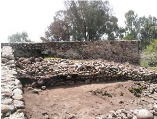
Fig. 7 Fachada principal lado sur. Muro lateral sur de las habitaciones del recinto superior, el piso corresponde al descanso del primer cuerpo, vista de oeste a este.
