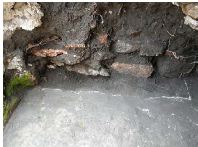
Fig. 6 Detalle del chafalán de piso que indica la continuidad de la “banqueta” hacia el sur, y que después dobla hacia el este, formando el corredor de acceso. Vista de oeste a este.
