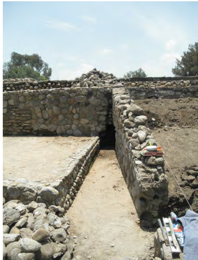
Fig. 5 Cala realizada en la esquina formada por la alfarda norte y el paramento reconstruido. Al fondo, el muro reconstruido que abarca todo el frente de la fachada principal.
