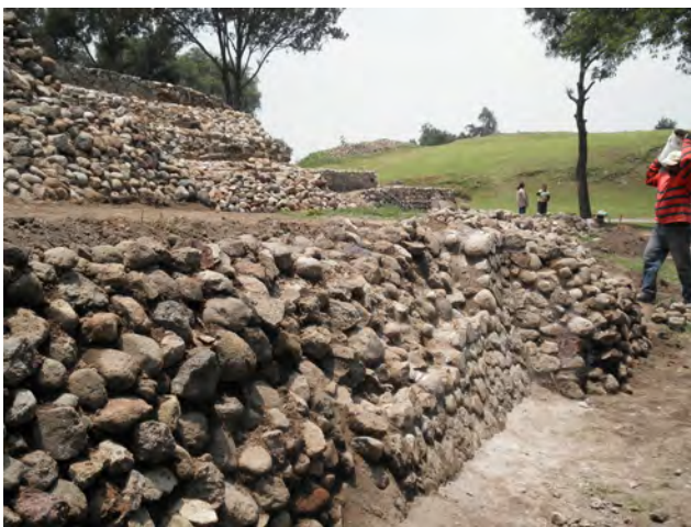
Fig. 20 Esquina NE del brazo transversal norte. Vista de este a oeste.
