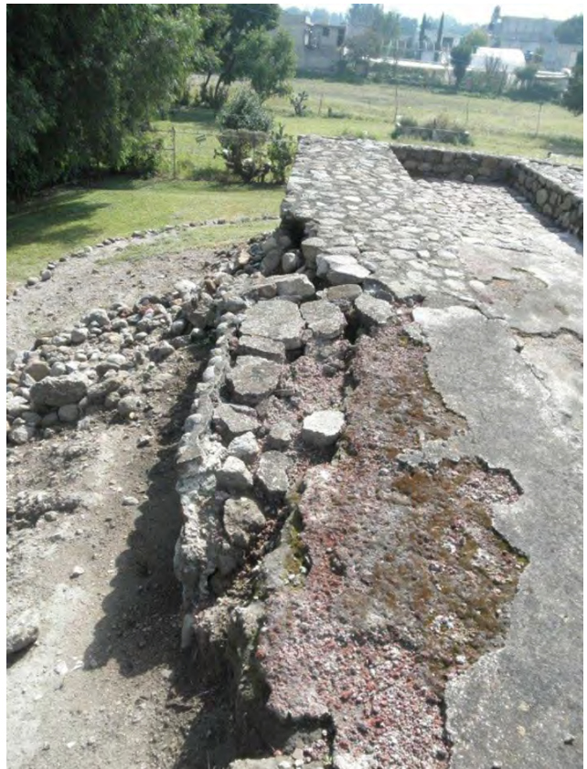
Fig. 32 Detalle de la figura 31. Extremo SE. Vista de oeste a este.
