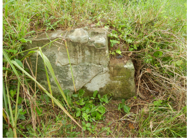
Fig. 8 Muro perimetral. Foto de: María Rosa Avilez Moreno.
