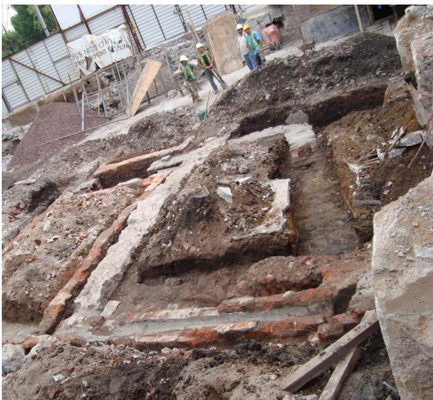
**Figs. 3 y 4** Arriba: demolición de zapatas de cimentación ubicadas bajo la losa tapa. Abajo: excavación extensiva en el espacio libre de losa base. Véase al fondo la losa base de la sección oriente del predio. *Idem.*
