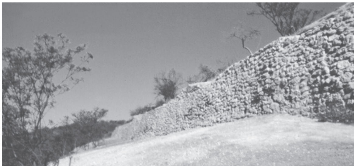
● Fig. 6 Muro de contención en Loma Sur.
