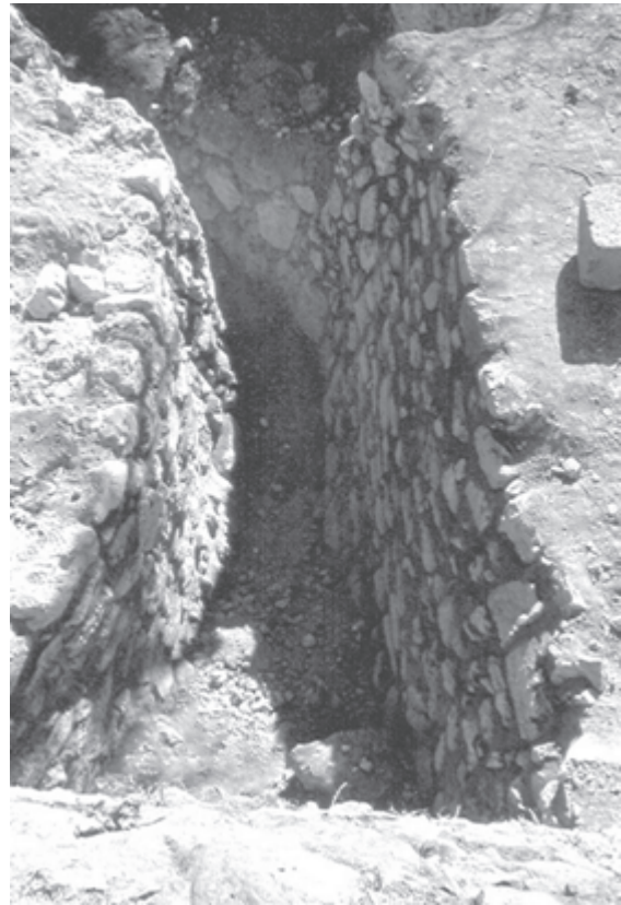
● Fig. 9 Foso excavado en la roca misma del cerro, con las paredes recubiertas de piedras calizas.
