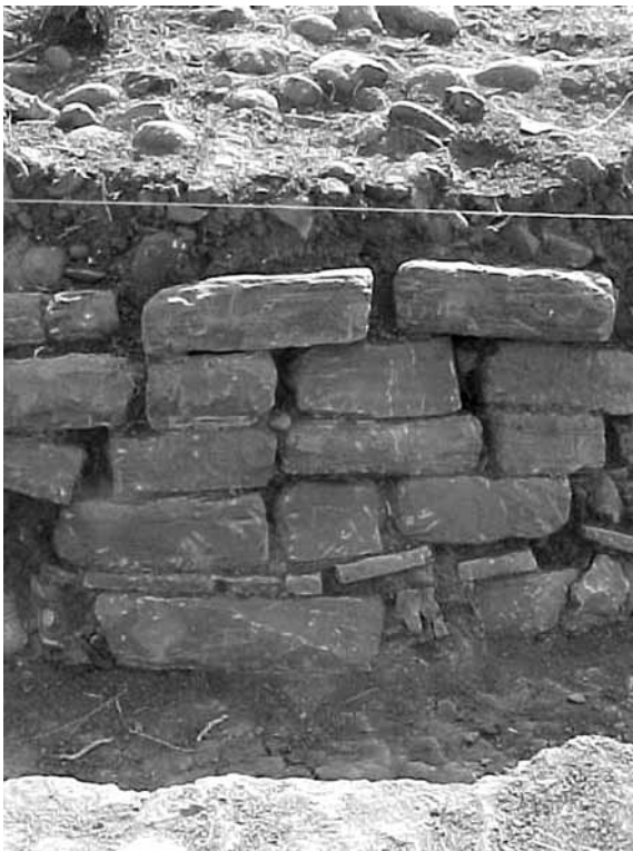
○ Fig. 10 Detalle muro aparente.
