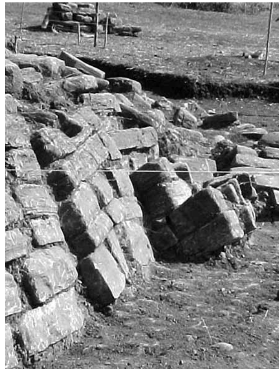
○ Fig. 11 Unión desplazada entre lienzos.
