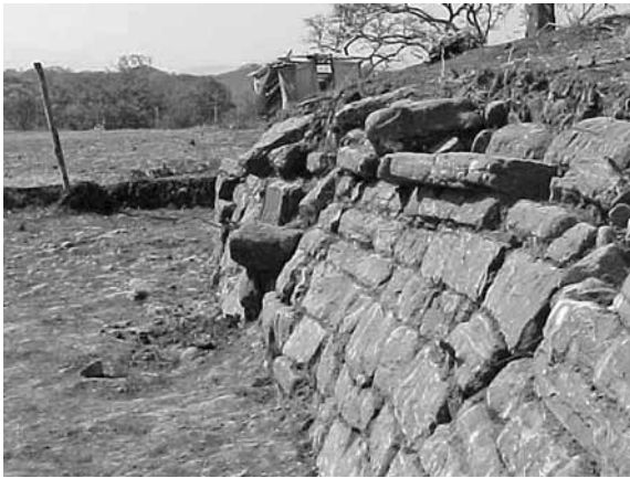
● Fig. 29 Vista al sur del muro con cornisa de la Estructura 6.
