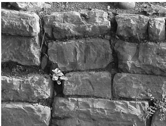
● Fig. 13 Muro aparente formado por lajas sin cuatrapear.
