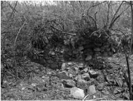
◉ Fig. 16 Muro de contención de terraza.
