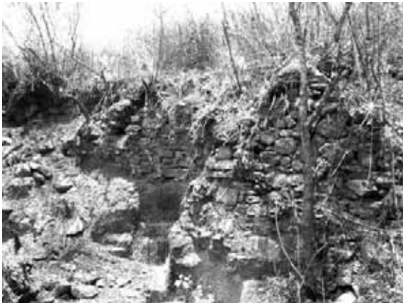
◉ Fig. 17. Muro de contención de terraza y cantera.
