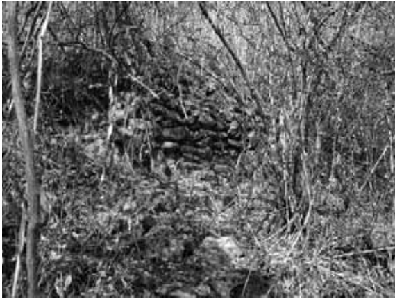
◉ Fig. 15 Muro de contención de terraza.
