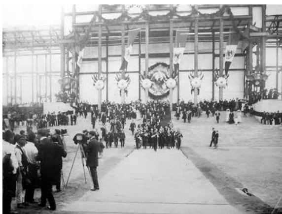
● Fig. 3 Colocación de la primera piedra del Palacio Legislativo, por el general Díaz (Montes y Ghigliazza, 2010: 274).
