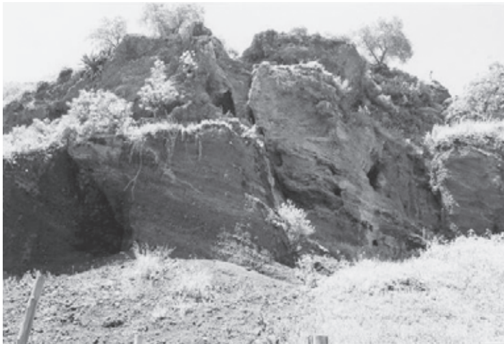
● Fig. 14 Deslizamiento de material en una ladera inestable y génesis de cavidades por procesos gravitacionales.
