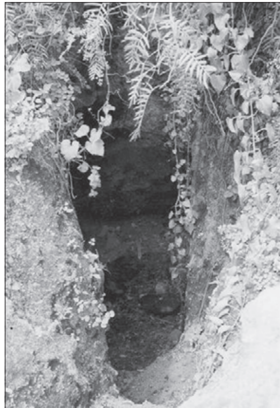
● Fig. 9 Erosión hídrica formadora de surcos de erosión y, en consecuencia, generadora de cavidades superficiales.
