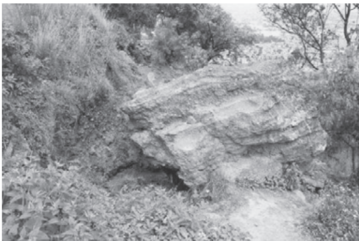
● Fig. 15 Peñasco desprendido de una ladera del Cerro de la Estrella.
