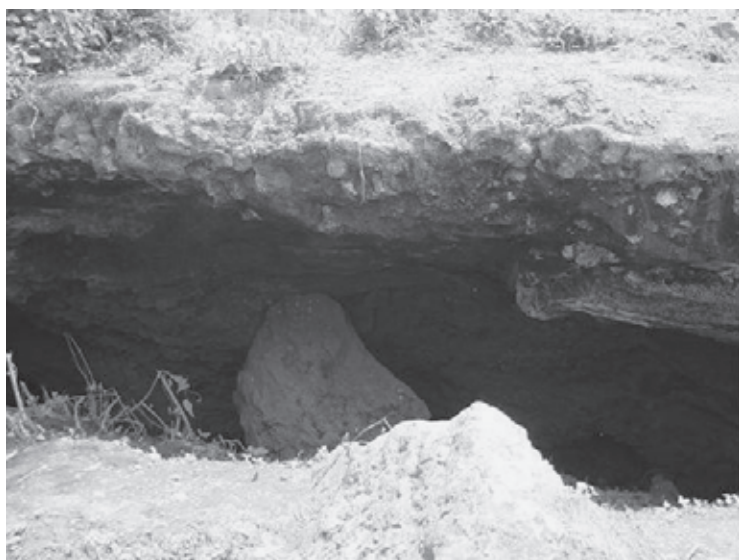
● Fig. 18 Cavidad natural originada por los fenómenos de socavación y derrumbe.
