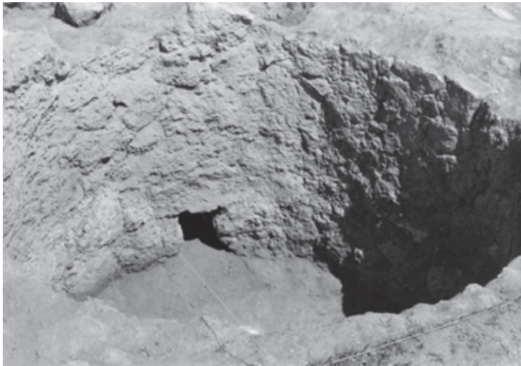
● Fig. 12 Hacienda Calderón. Mitad inferior de cuba y puerta de alimentación de leña y retiro de cenizas.
