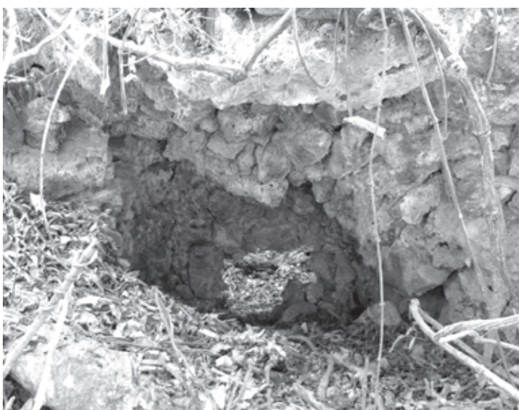
● Fig. 15 San Andrés de la Cal. Abertura para la alimentación de leña.
