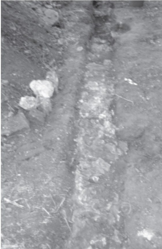
● Fig. 12 Arranque de un muro perteneciente a un tanque de miel mayor en la casa de calderas.
