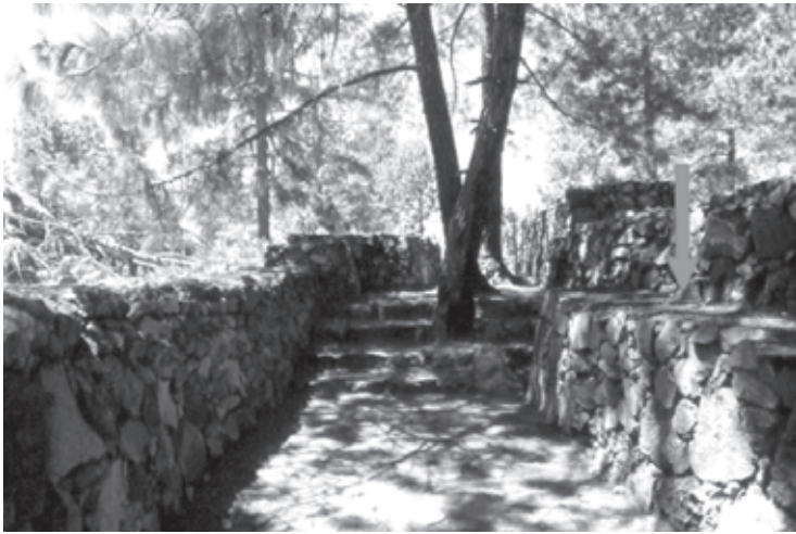
● Fig. 22 Otra sección de la Calzada 1, donde se construyen escalones para salvar los cambios topográficos. A la derecha, un ejemplo de contrafuertes interiores.
