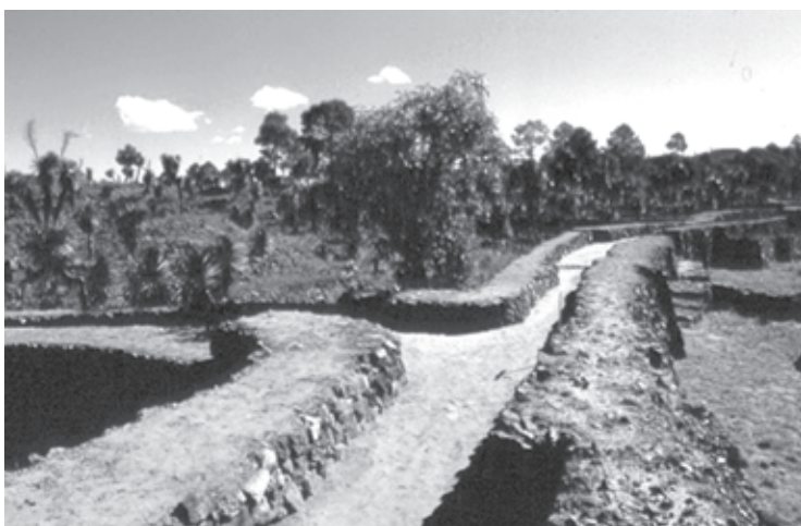
● Fig. 19 Sección de la Calle 1, donde se observa el desfase de los laterales después de la unión de esta vía con otra calle.
