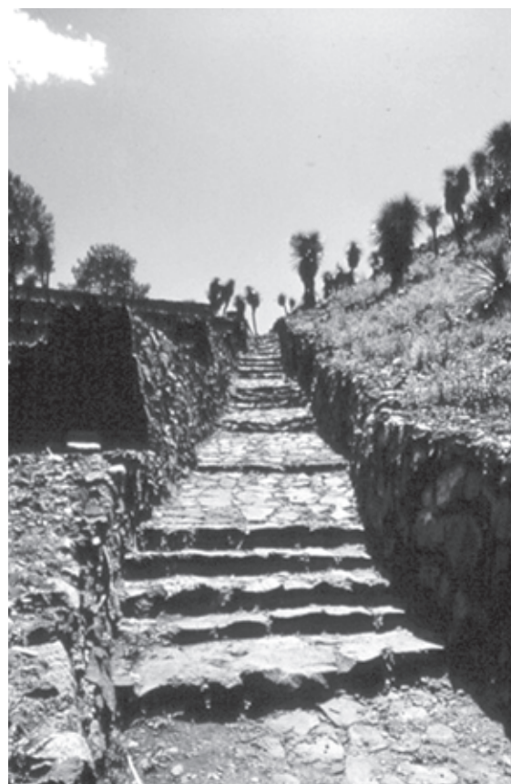
● Fig. 33 Rampa escalonada al final de la Calzada 1.
