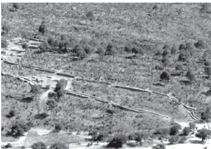
● Fig. 6 Calzadas 1 y 2, vista general desde el Cerro Las Águilas, al Poniente del sitio.
