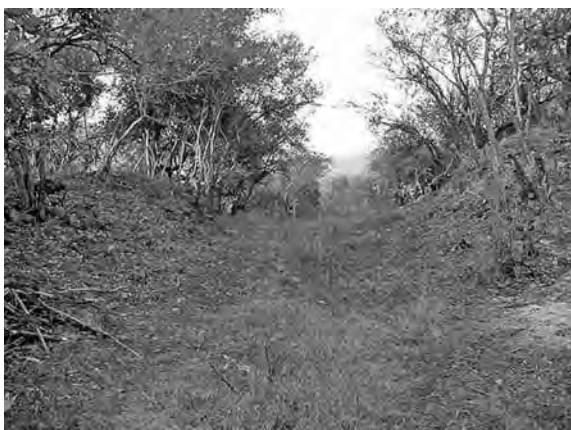
● Fig. 22 Destrucción de otra plataforma, partida a la mitad para el paso de vehículos.
