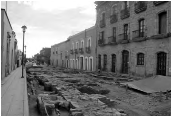
● Fig. 16 Exploración de los cimientos del convento en la calle de M. F. Fiallo.
