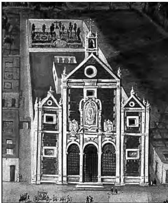
● Fig. 5 Detalle de la iglesia de Corpus .
