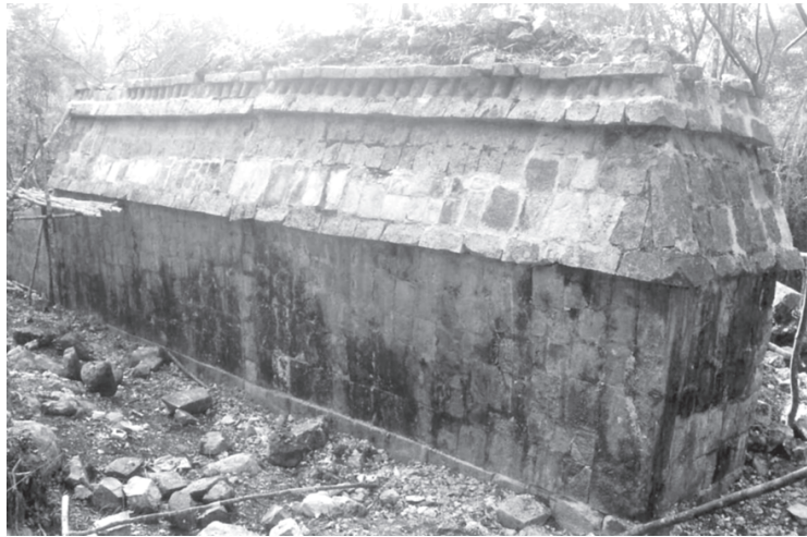
● Fig. 16 Fachada norte del Edificio 4 después de su restauración.
