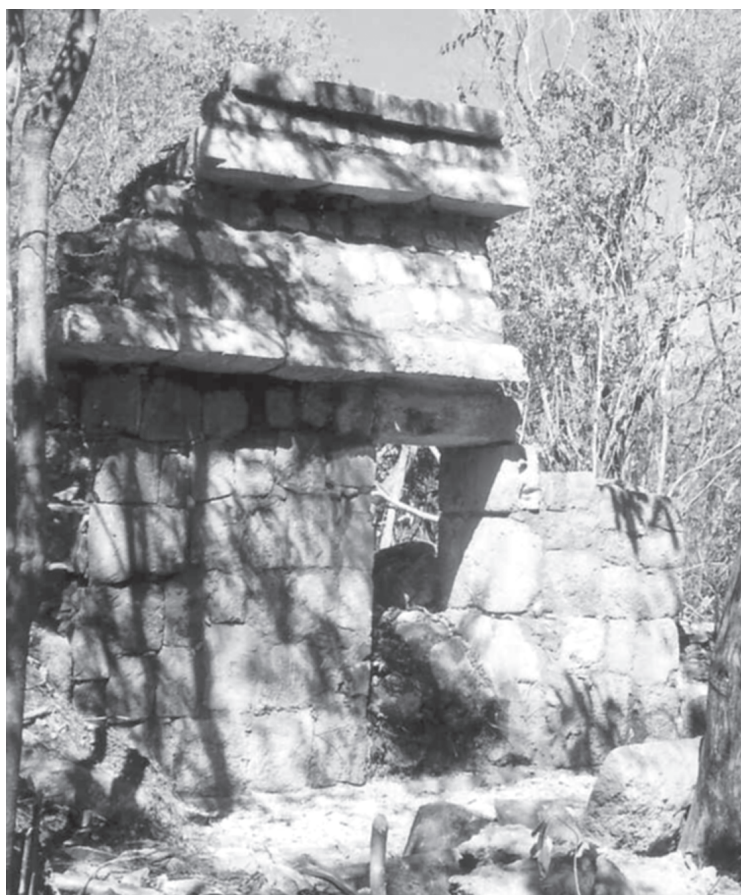
Fig. 27 Edificio 24 al término de los trabajos de consolidación.
