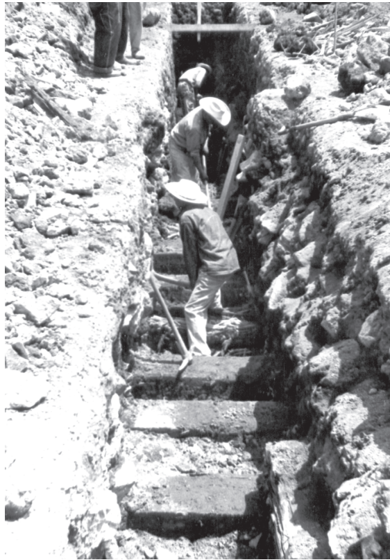
● Fotografía 8 Vigas que forman el emparillado de madera sobre las que descansa un núcleo de piedras.
