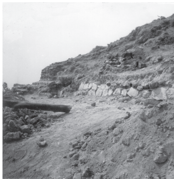
● Fig. 6 Vista hacia el suroeste del talud de la parte sur.
