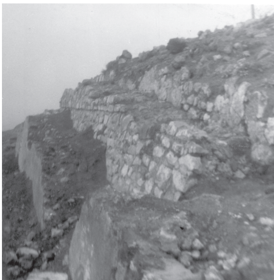
● Fig. 1 Aspecto de los Taludes de la parte sur.
