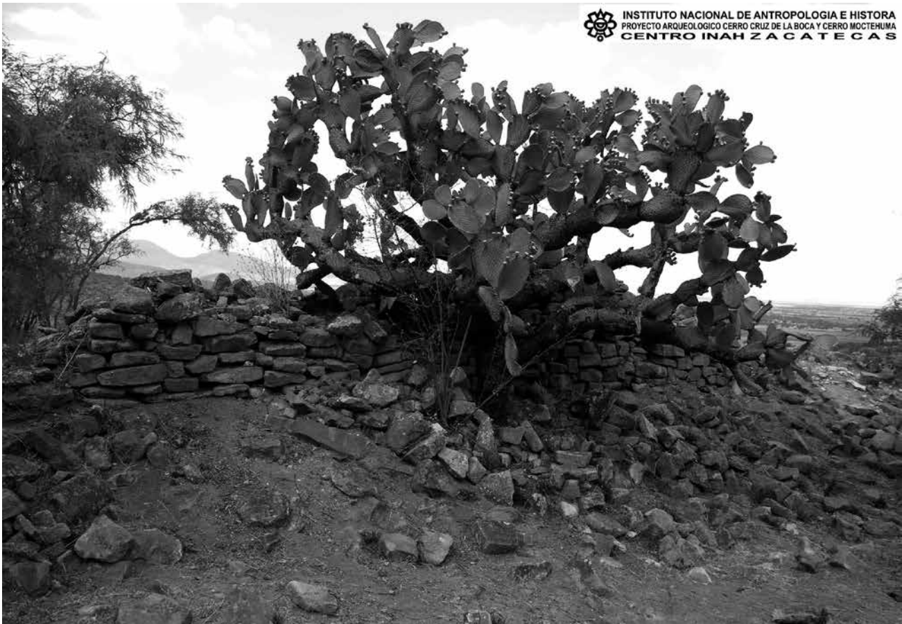
Fig. 6 Foto exterior de los restos aún en pie del muro perimetral suroeste del Gran Salón, anexo al grupo Patio (o Plaza) Principal en las ruinas de los edificios de Moctezuma.
