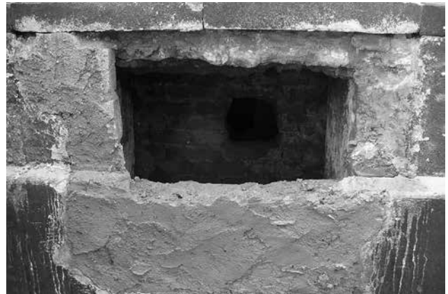
Fig. 19. Calas arquitectónicas de cimentación. Fotografía: Ma. de Lourdes López Camacho.
