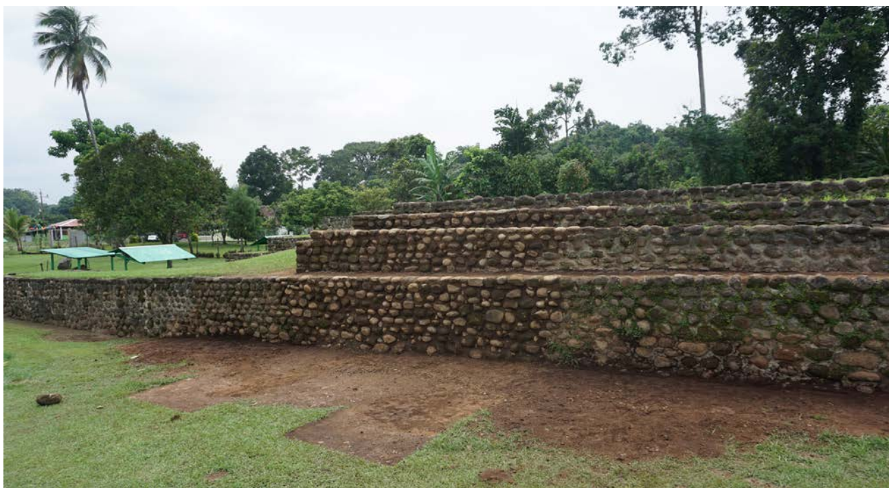
Fig. 11 Plataforma basal de la estructura 125 y esquina sureste de la estructura 125-B del Grupo F, concluidos los trabajos de restauración.
