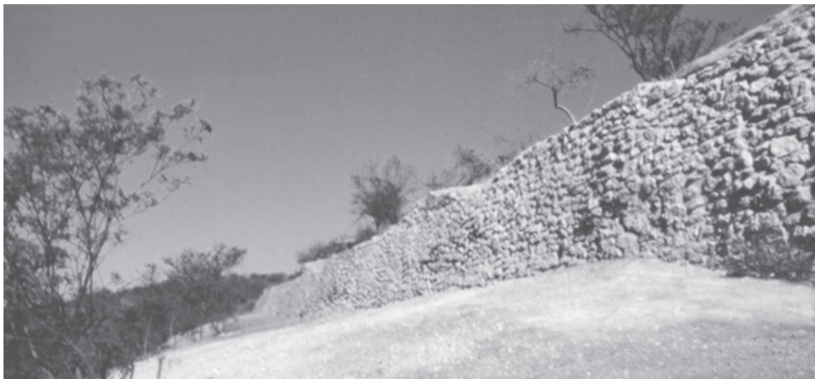
● Fig. 6 Muro de contención en Loma Sur.
