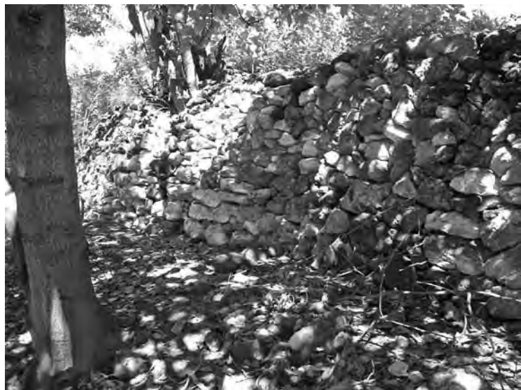
© Fig. 18 Muro de contención al interior del sitio.
