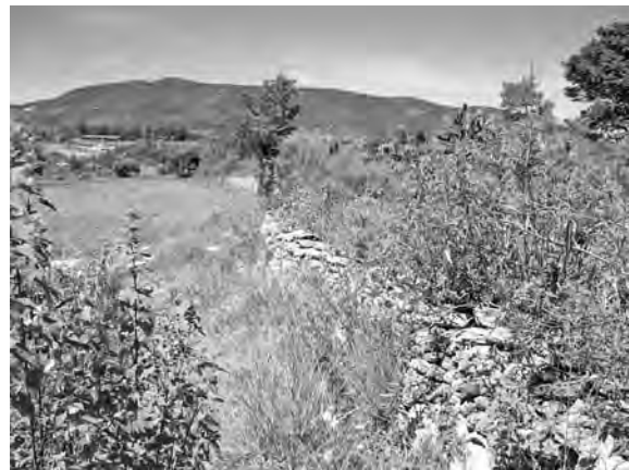
● Fig. 22 Muro de contención de terraza agrícola.
