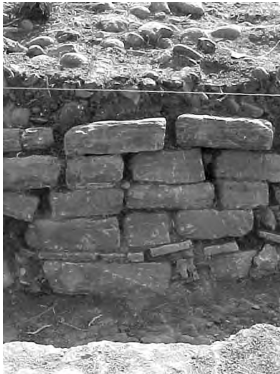
© Fig. 10 Detalle muro aparente.
