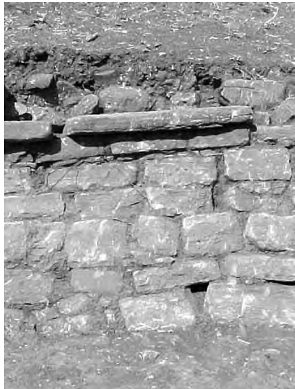
© Fig. 30 Detalle cornisa y rajuelas bajo las lajas para nivelarlas.
