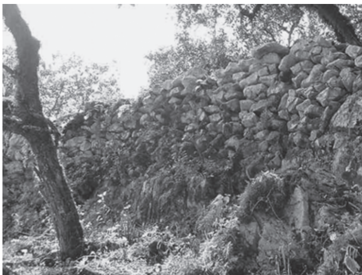
● Fig. 9 Muralla de plataforma superior. Obsérvese la ubicación de las rocas naturales para formar la base de la muralla.
