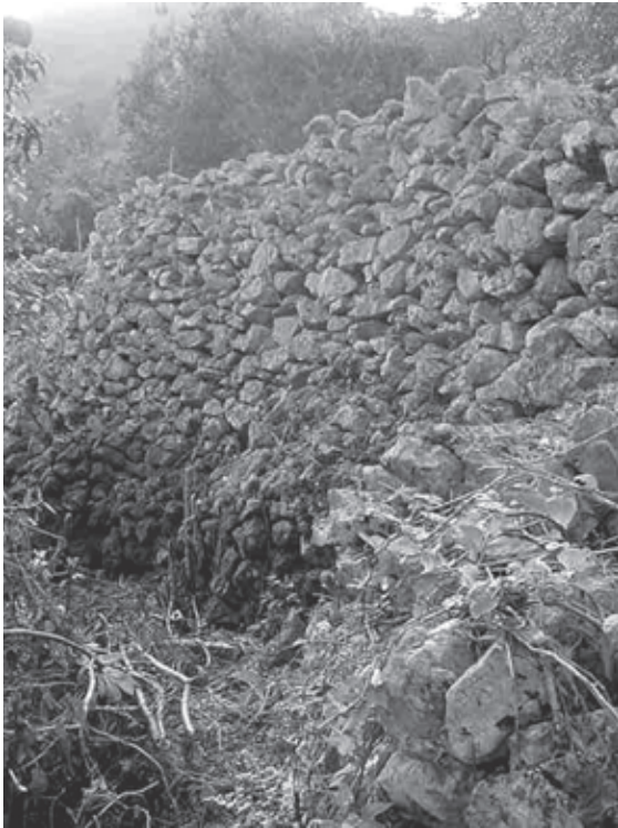
● Fig. 14 Muro este de la plataforma inferior. Obsérvese el tipo de aparejo y las proporciones de la edificación.
