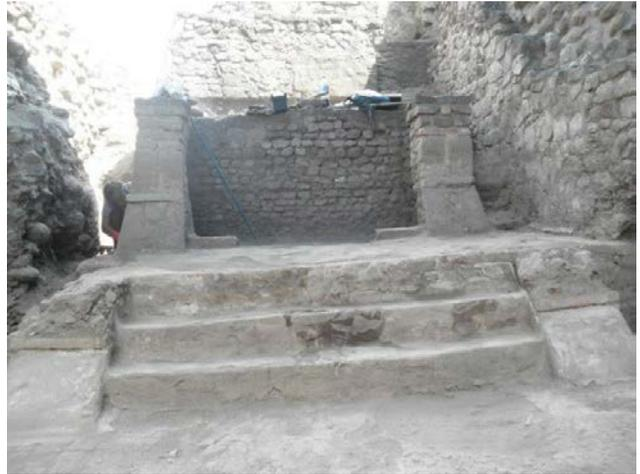
**Fig. 13** Alfardeas, escalinata y templete con paramentos laterales que forman el acceso, los cuales están revestidos de ladrillos.
