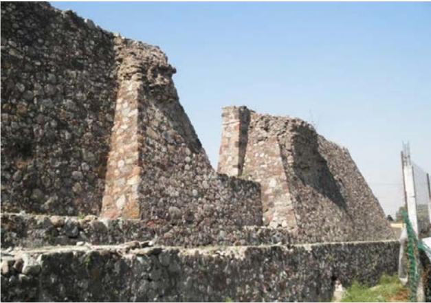
**Fig. 6** Detalle de la toma anterior. En la foto se puede observar parte del relleno original que sobresale de los muros en talud, así como el supuesto camino de ronda y almenas.
