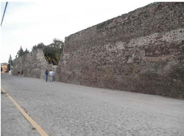
**Fig. 35** Sección norte. En la foto se puede observar el corte en su parte media a partir del primer cuerpo que parece indicar la existencia de otro vano de acceso. Vista de sur a norte.
