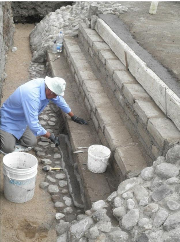
**Fig. 39** (izq. arriba) Integración de adobes en la escalinata central de la plataforma basal y consolidación del núcleo de las alfardas y escalinatas laterales. Vista de sur a norte.
