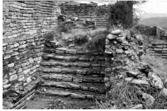
● Fig. 16 Material de construcción: piedras careadas de muy buena calidad.
