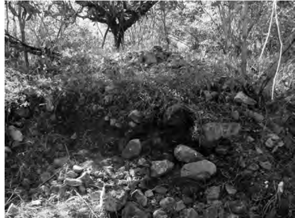
◉ Fig. 21. Estructura dañada en uno de sus lados.
