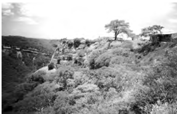
● Fig. 11 Modificación para evitar el desgajamiento del cerro por fenómenos naturales.
