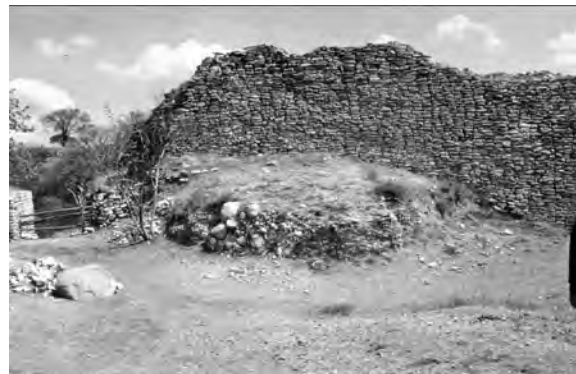
● Fig. 29 Aljibe o cisterna que sirvió para recolectar agua pluvial en la fortaleza de Tepexi.
