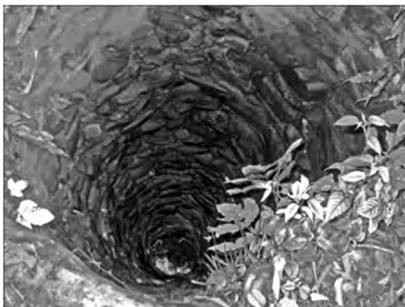
© Fig. 4 Interior de uno de los pozos en secas con perímetro recubierto de lajas.
