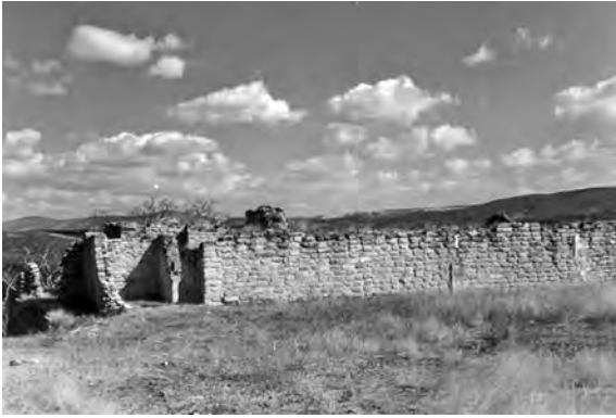
Fig. 24 Los muros de las habitaciones fueron muy gruesos y alcanzaban más de 2 m de alto.
