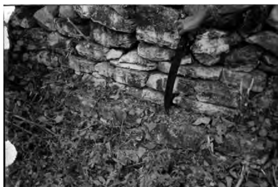
● Fig. 14 Por ejemplo, en el sitio PANQ-17 "San Marcos" los elementos constructivos se colocan "a hueso", es decir, sin cementante.
