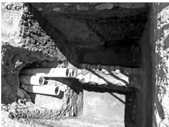
● Fig. 9 Muro del Pozo 5.
