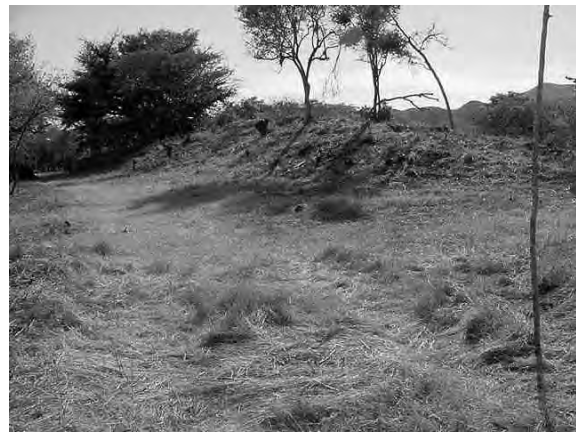
● Fig. 10 La cancha del juego y su muro lateral oeste luego de haberse limpiado.
