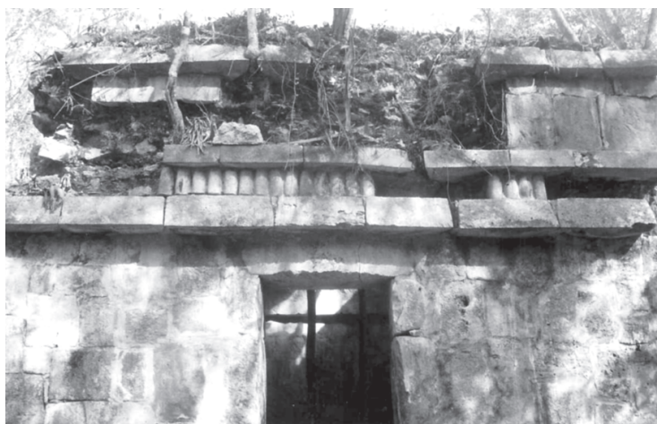
● Fig. 5 Fachada sur del Edificio 2 antes de su intervención.
