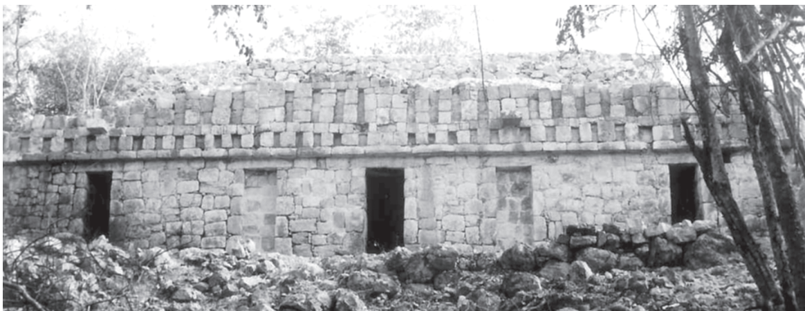
● Fig. 8 Fachada sur del Edificio 6 después de los trabajos de restauración.
