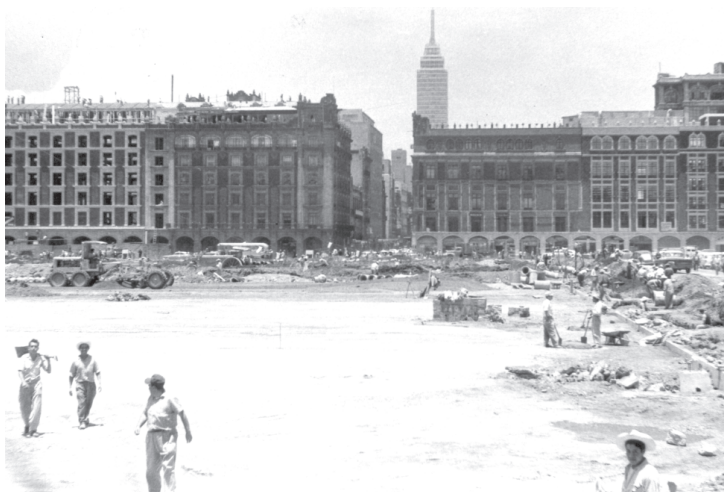
● Fotografía 2 Vista de la obra de transformación de la Plaza de la Constitución por la que puede apreciarse la forma en que se desarrollaron la actividad de dichos trabajos.
