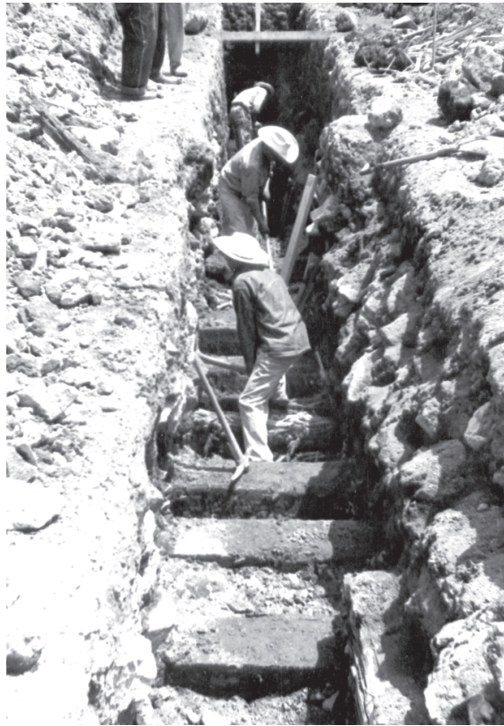
● Fotografía 8 Vigas que forman el emparillado de madera sobre las que descansa un núcleo de piedras.
