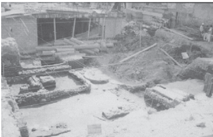
● Fig. 8 Unidades de excavación 1 y 2, habitaciones prehispánicas.
