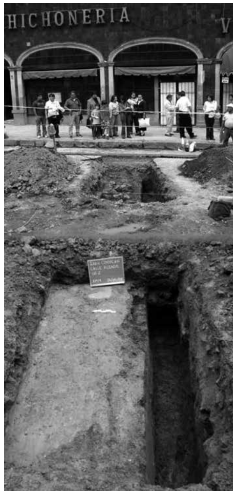
Fig. 8 Vista oeste-este de la estructura registrada en la calle de Allende.
