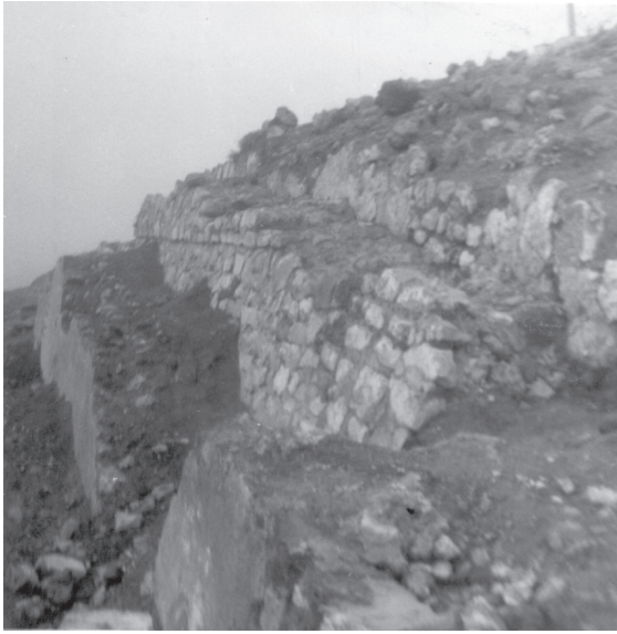
● Fig. 1 Aspecto de los Taludes de la parte sur.
