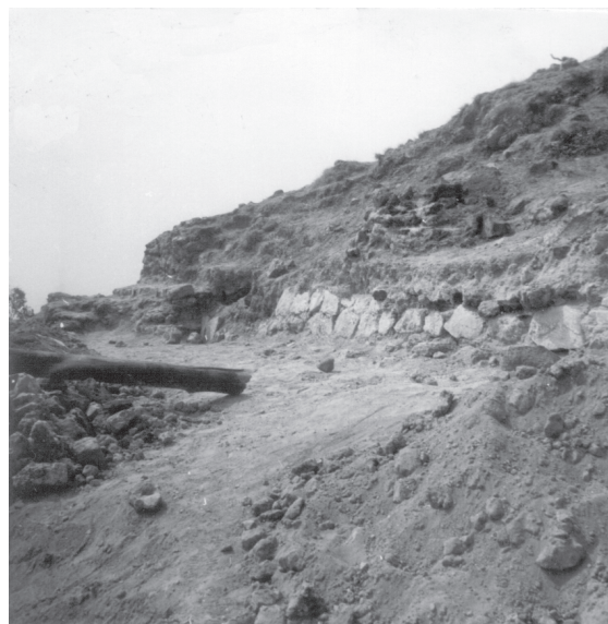
● Fig. 6 Vista hacia el suroeste del talud de la parte sur.
