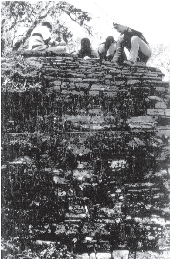
● Fig. 11 Vista posterior de un basamento sobre el que descansa una de las primeras hiladas del muro de la habitación superior.
