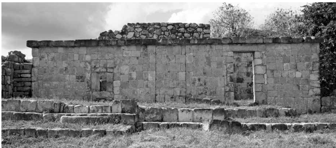
● Fig. 15 Fachada oriente del baño de vapor de Oxkintok (vano de la izquierda).
