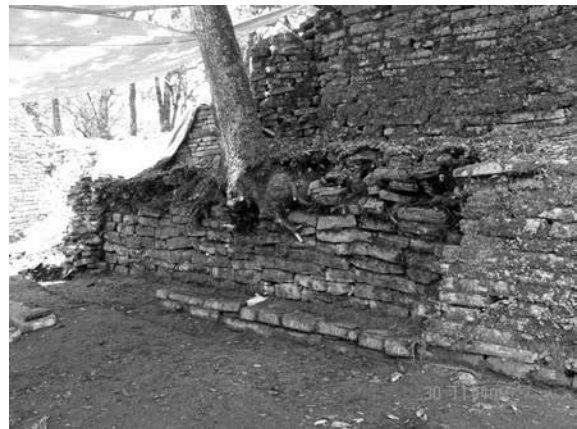
● Fig. 32 Subestructura del paramento Oeste del juego pelota 1.
