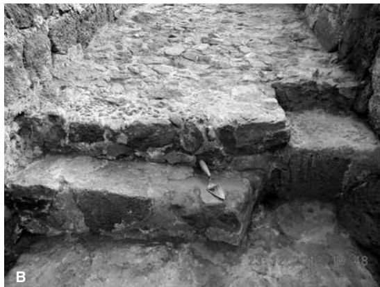
● Fig. 32 Primer tramo de escalera, antes y después de la intervención.
