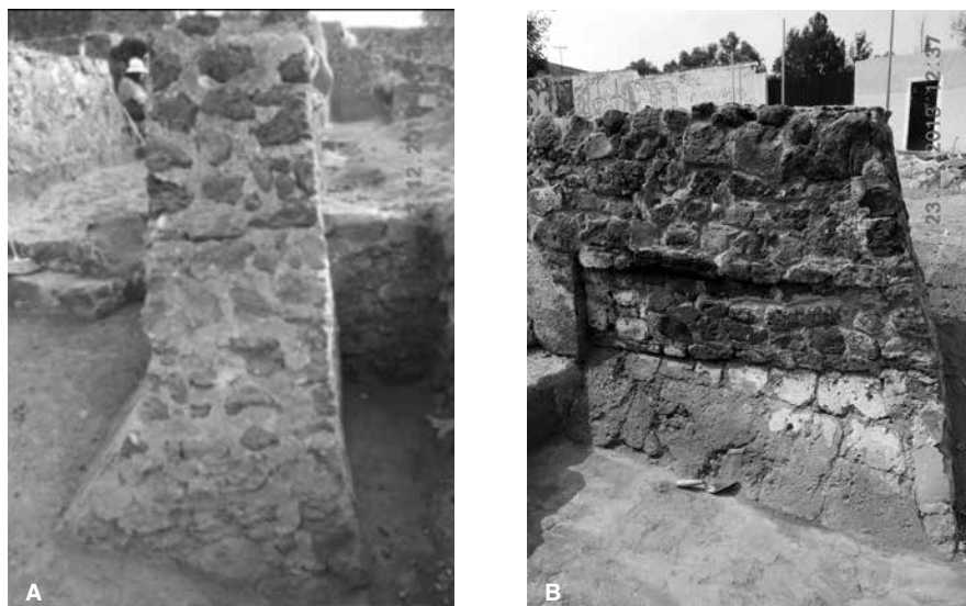
● Fig. 17 Parte final del muro, en el cual se observa las diferentes intervenciones que ha tenido en su restauración.
