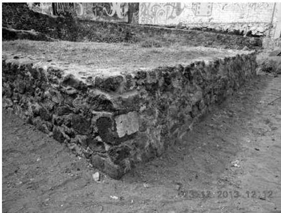
◉ Fig. 12 Aspecto final de la Plataforma 1 después de la consolidación.
