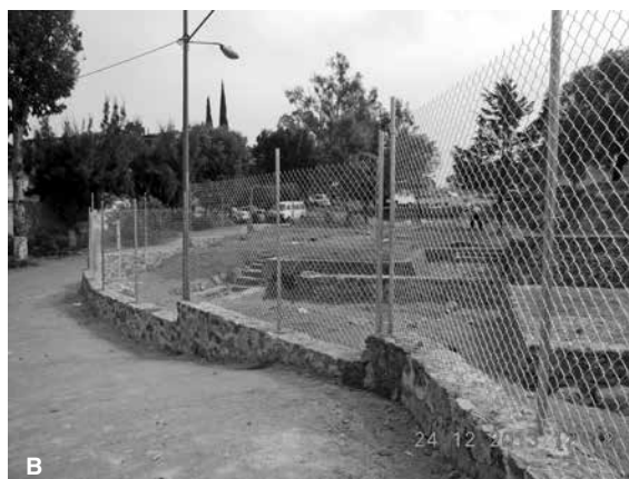
● Fig. 36B Aspecto final del muro perimetral en el extremo noreste de la zona.
