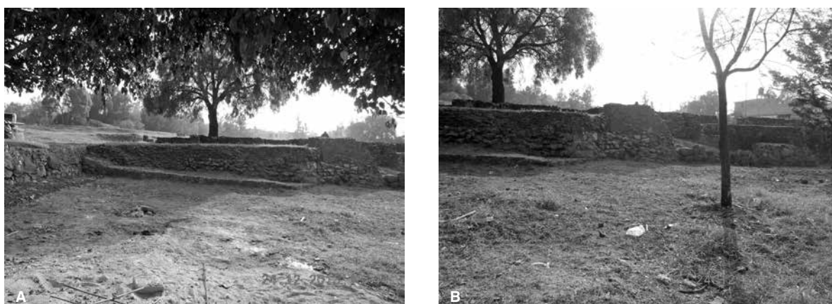
● Fig. 25 Vista panorámica del muro norte de la Plataforma 3, ya restaurado y consolidado.
