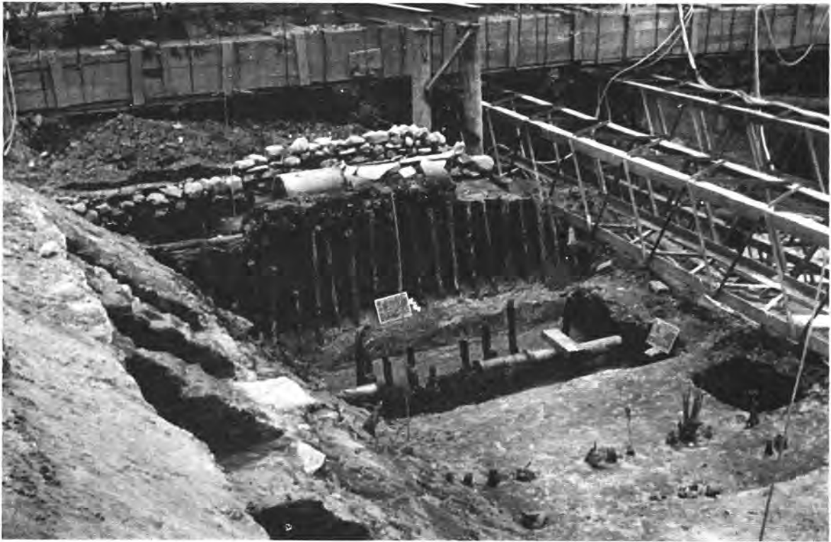
● Fig. 1 Pilotes correspondientes al sistema constructivo del Tezontlalli, tubería vidriada y drenaje porfiriano
