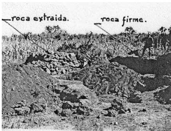
● Fig. 5 Excavación y cata número 4.
