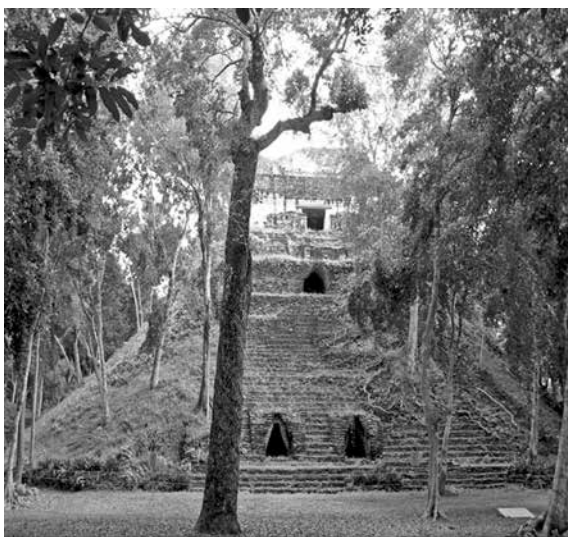
● Fig. 3 Edificio E-2.
