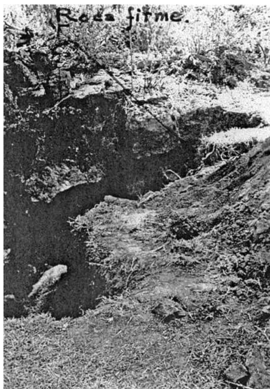
● Fig. 4 Excavación y cata número 3.
