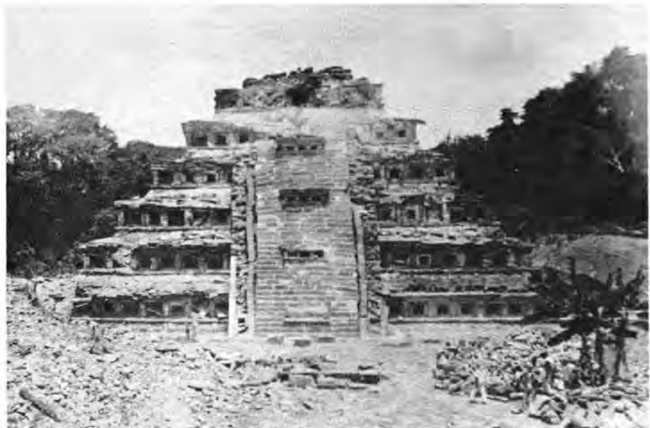
● Fig. 12 Aspecto del lado este tal como quedó al finalizar los trabajos en 1934 (foto 50).
