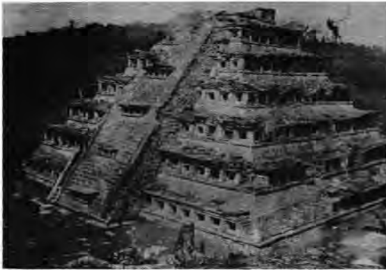
● Fig. 4 Aspecto de la pirámide de los trabajos de 1935 (foto 2).
