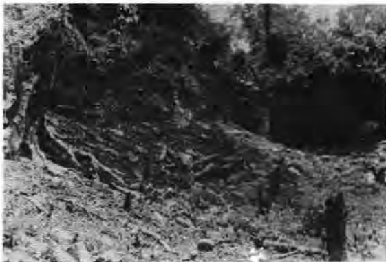
● Fig. 16 Aspecto de los edificios llamados Tajín Chico, antes de los trabajos (foto 74).
