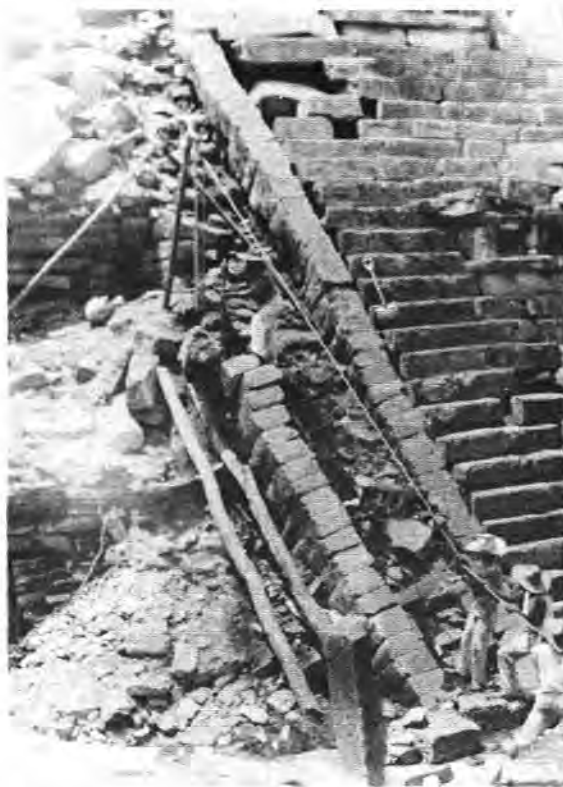
● Fig. 10 Otro aspecto de la misma (foto 43).
