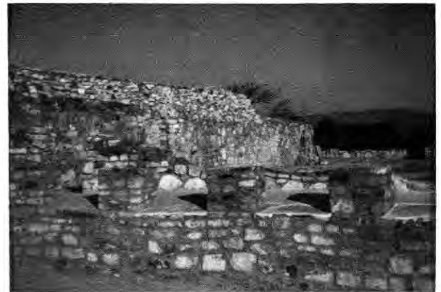
Foto 2. Basamento de la Estructura 11 con tablero en escapulario.
