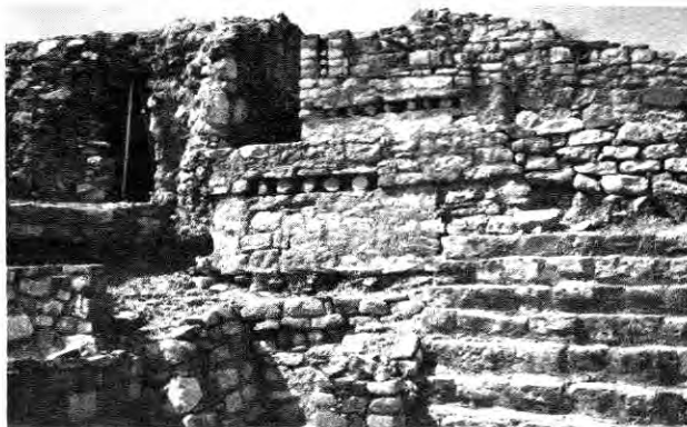
Foto 3. Estructura 5 recién restaurada.
