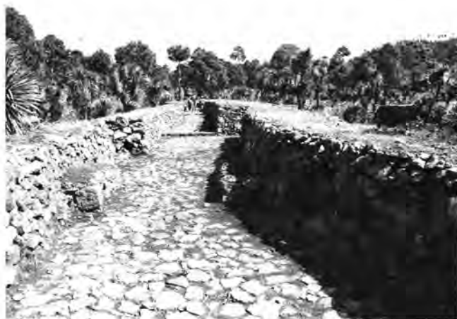
Figura 8. Vista parcial de la Calzada 1.
