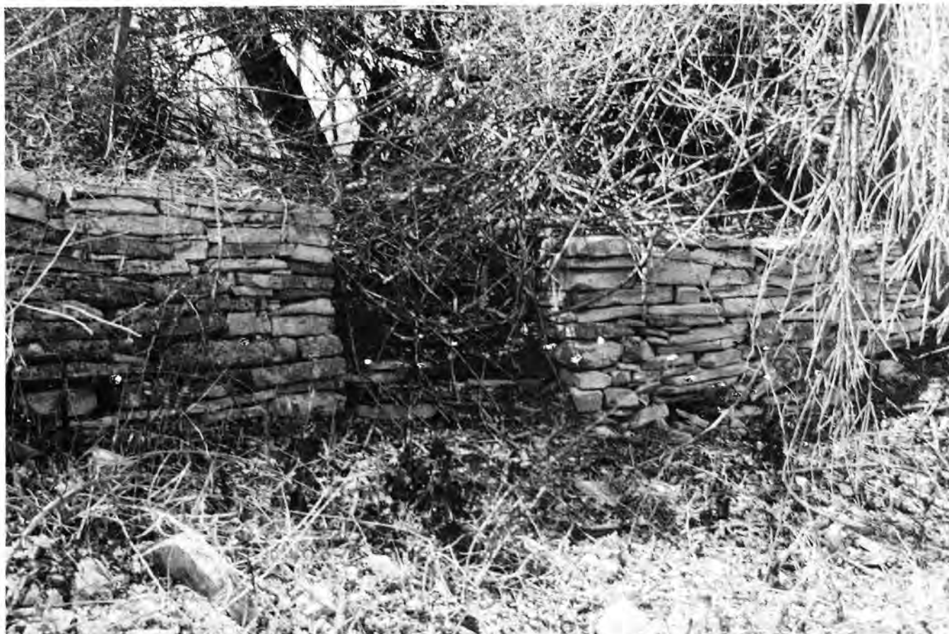
Figura 7. Muro que conforma una terraza con escalera de acceso.
