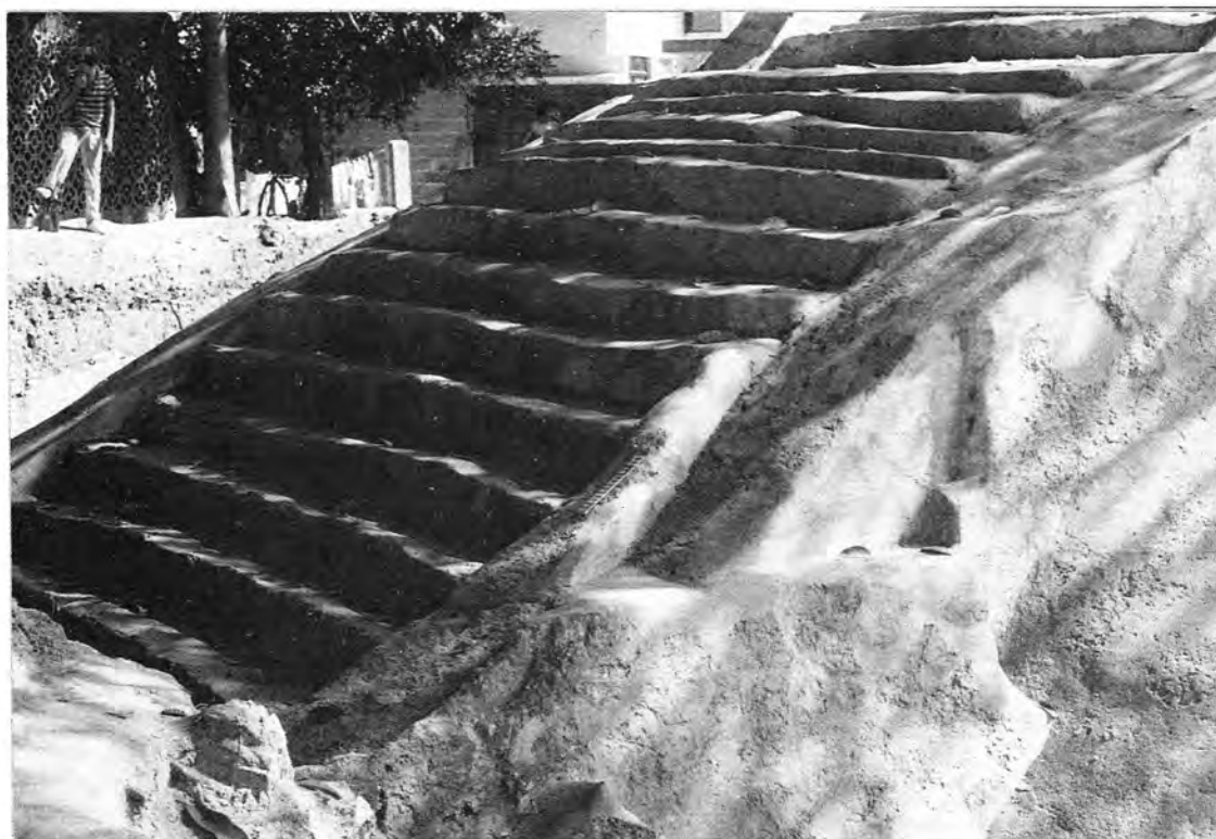
Figura 6c. Aspectos que presentaba el montículo casi al final de los trabajos.
