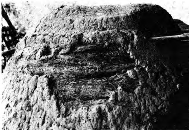
Foto 8b. Sitio Las jarillas. Detalle del granero número 4. La pérdida del enjarre dejó al descubierto los haces de paja. En el ángulo superior derecho se observa un travesaño de madera.
