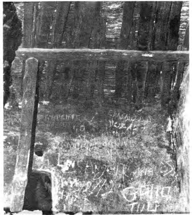
Foto 12b. Sitio Cueva Grande. Detalle que permite apreciar la viga maestra, los polines y la "cama" de tallos de maíz en el segundo piso de la casa 2.
