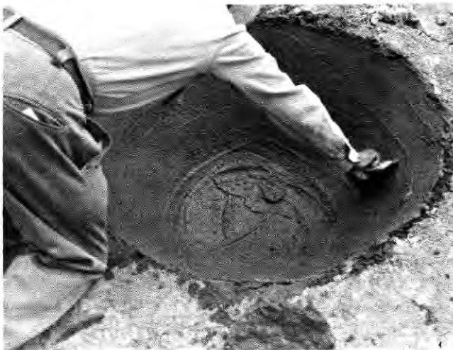
Foto 2. Preparación de la superficie de una pila, Nexquipayac.
