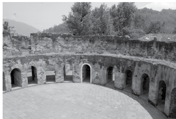
Figura 4. Patio de las celdas de la torre circular. Fotografía de Alberto Garín.
