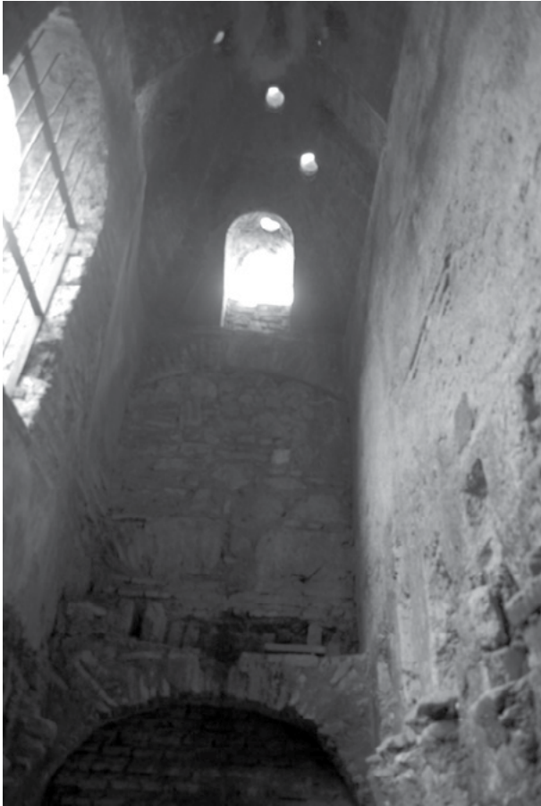
Figura 12. Sauna de la torre. En la parte inferior se observa uno de los arcos del hipocausto, así como en la parte superior se ven las aberturas cilíndricas de la bóveda. Fotografía de Loren Lemus.
