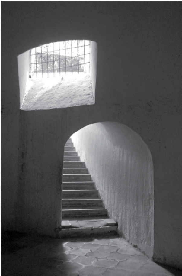
Figura 13. Cisterna de la torre. Se observa la escalera de acceso a la cisterna, así como la ventana por la que entraba el agua de lluvia. Fotografía de Loren Lemus.
